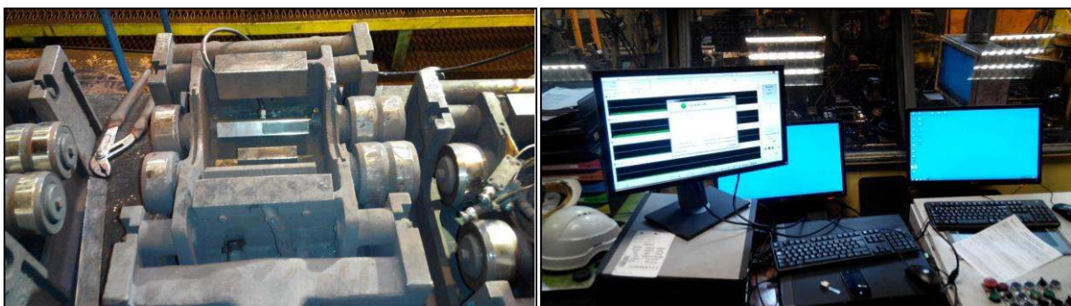
Figure 20 – Sonde installée dans le banc US de l'usine de Saint-Saulve (gauche) et équipement Metalscan dans la cabine
